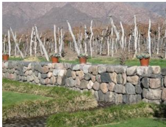
Pirca que separa al viñedo del terreno
