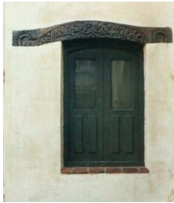
Ventana con dintel grabado y marco de ladrillo
